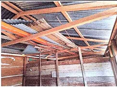
Foto 3: Entechado de la cocina.
