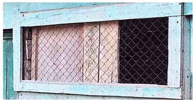
Foto 4: Malla galvanizada de la cocina
