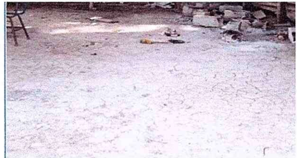
Foto 2: Piso de la cocina.
